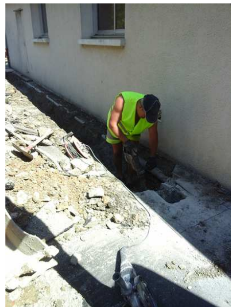
Réfection des réseaux au réfectoire
